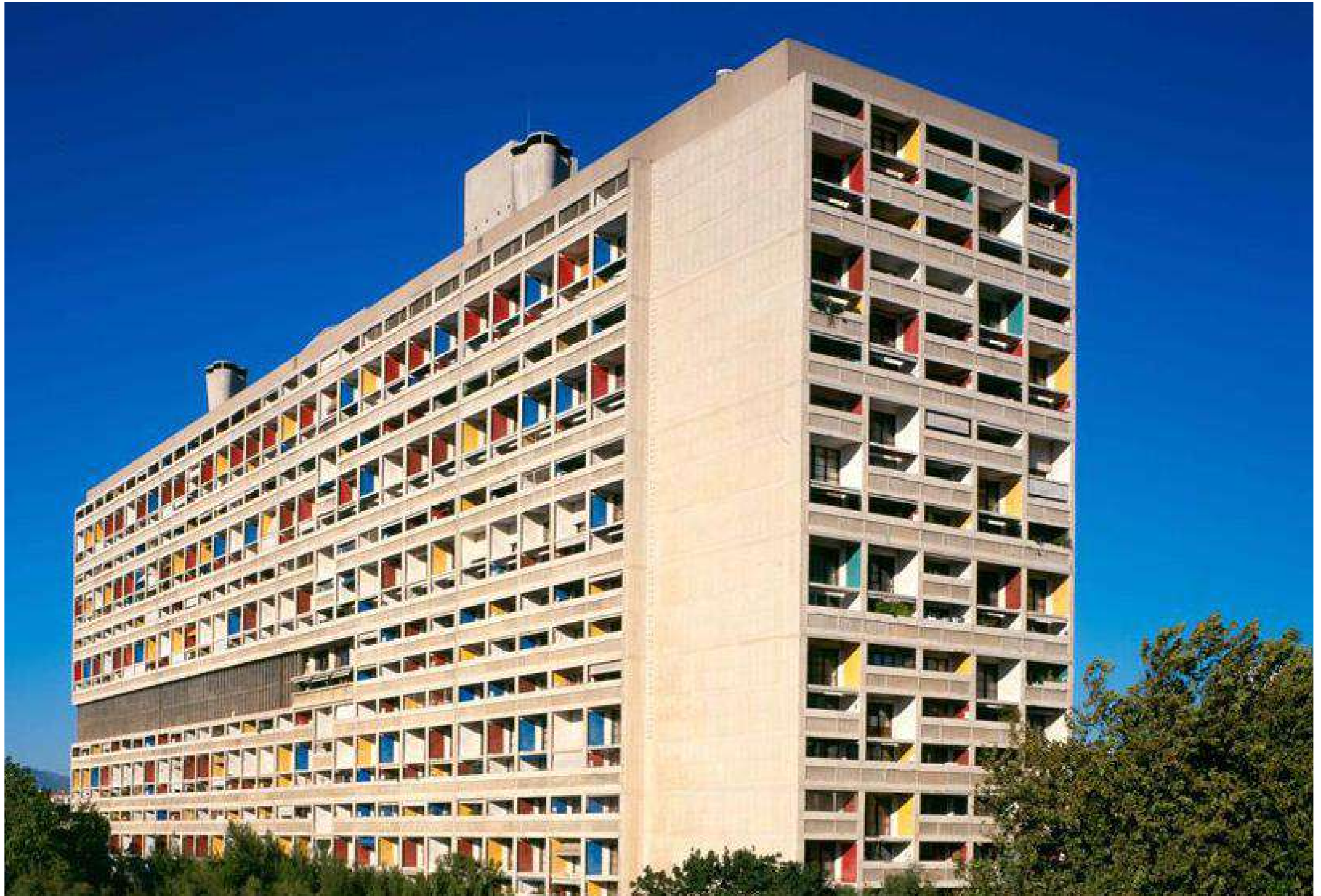
Unité d'habitation Marseille, France 1945
